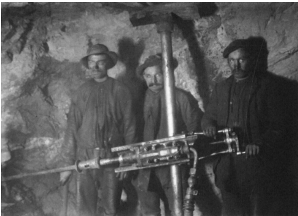
Gravhalsen tunnel til Myrdal var ei utfordring. Den tok seks år å ferdigstille, og vart gravd fram med vassdrivne hydrauliske handro-tasjonsboremaskinar
