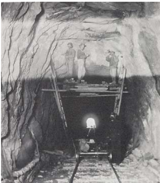
Utgraving av Risnes tunnel ved Sørfjorden på Vossebanen.
