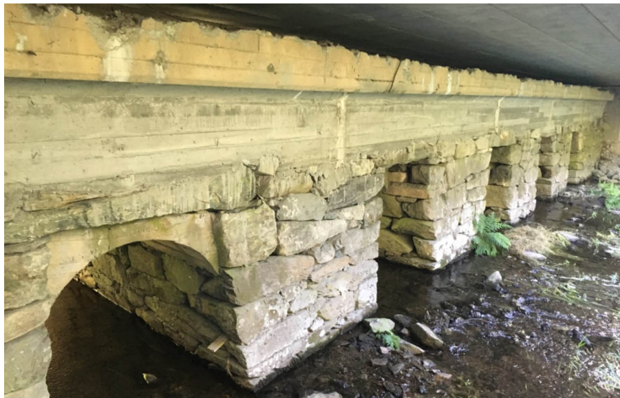
Torve bro ved Søfteland, bygd 1811-1812 av Jochum Hagerup Moss etter anvisning av C. J. Hammer. Den nye broen er støpt over den gamle.
