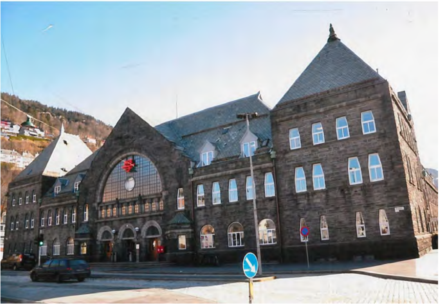
Arkitekt Jens Z.M. Kielland er mester for Bergens prektige jernbanestasjon som ble reist i årene 1909-1913. Foto: GAS
