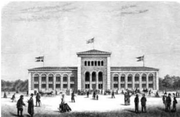
Bergens Museum stod ferdig i 1865. Arkitekt var dansken Nebling.
