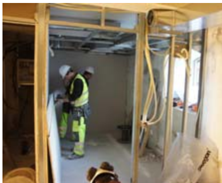
Katakombene i kjelleren skal bli dusj og garderobe
