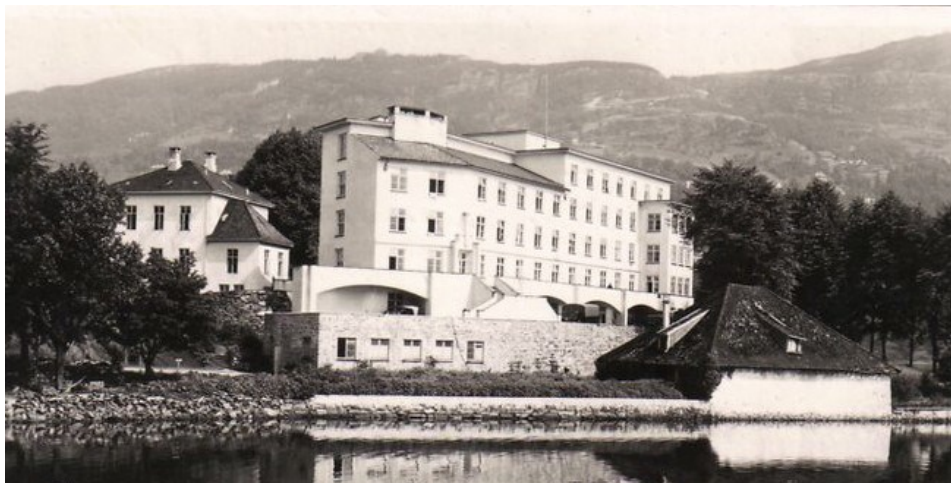
Den nye bygningen Florida sykehus stod ferdig i 1937 og var tegnet av Ole Landmark..
