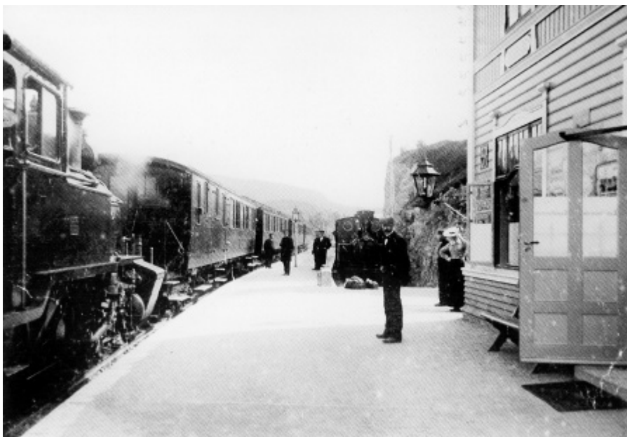
Nestun stasjon. Vossebanen til venstre, Osbanen til høyre.
