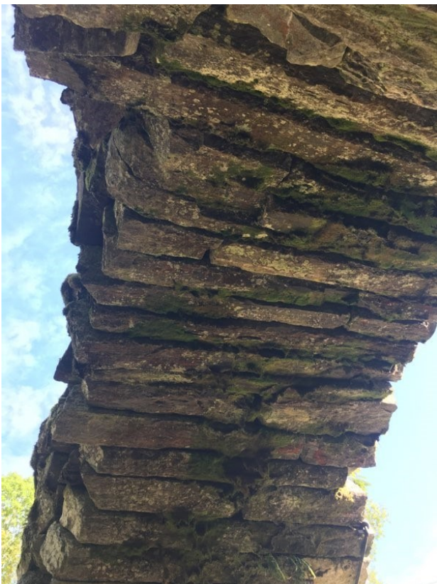
Kvelvinga i brua var laga av rundt to meter lange, perfekt tilpassa steinar. Fotografert 21. juli 2018.
