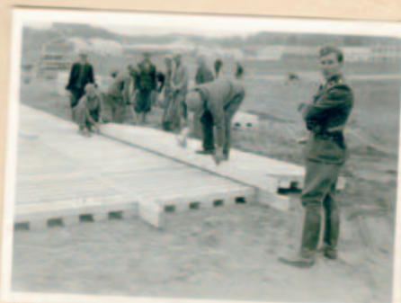
Verbindung dreier Bohlentafeln
