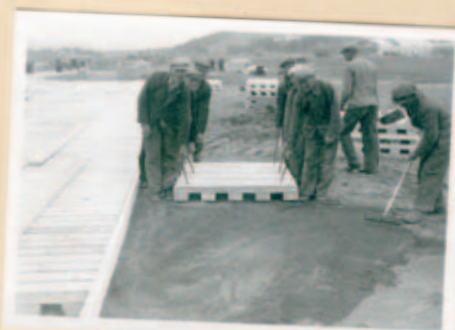
Bohlentafel - Startbahn; Sand zwischen Schicht
