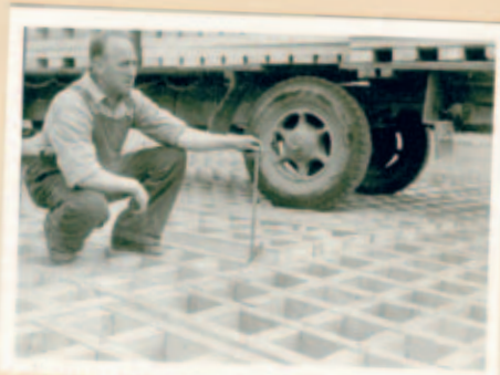
Aufwippen eines unversehrten & unbeschädigten Wabenrosts bei Belastung
