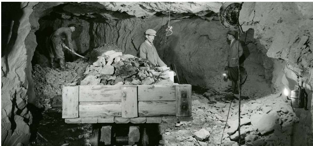
Tunnelbygging på Burøya. Fotograf Helgesen. Samling etter Erling Sandnes. Arkiv i Nordland.
